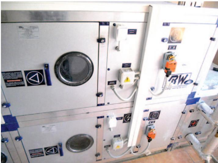
Оборудование для приточно-вытяжной вентиляции, обеспечивающее защиту от туберкулезной инфекции.
